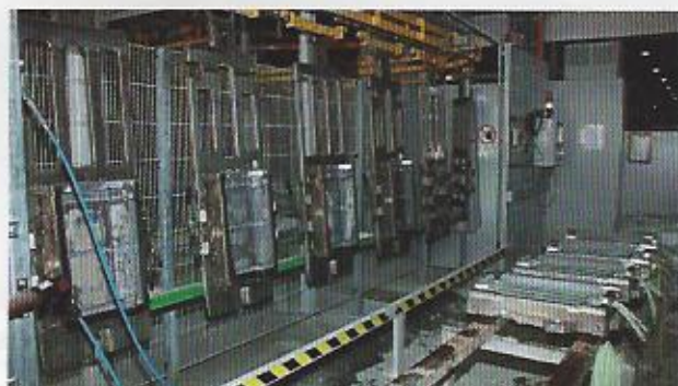
»4 ARA2 buffer section and mould removal »4 Pufferstrecke und Formenentnahme an der ARA2
